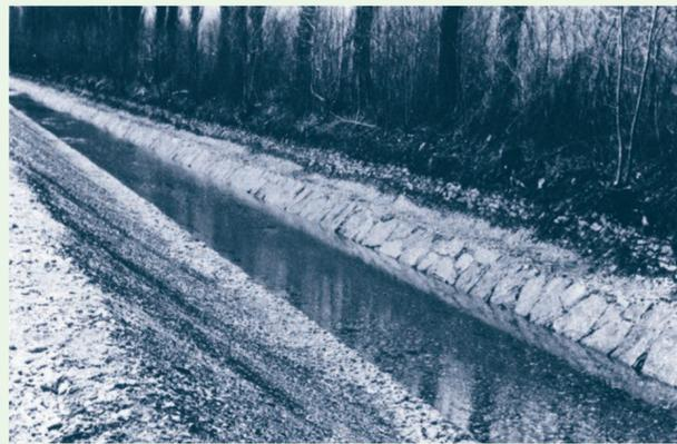
Neue Saar mit abgesenkter Sohle und Uferpflasterung, 1970
